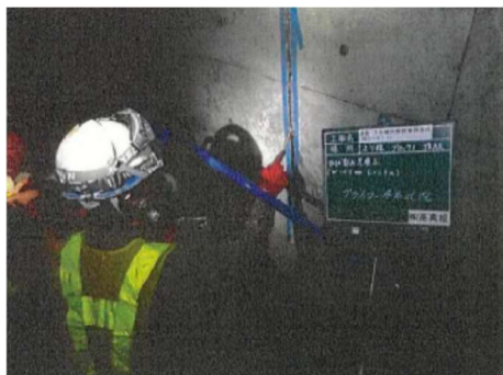
写真1 ひび割れ注入工
