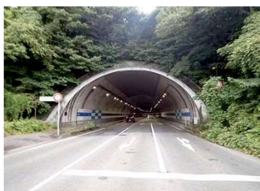
矢作トンネル
