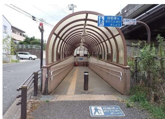
土気地下歩道
