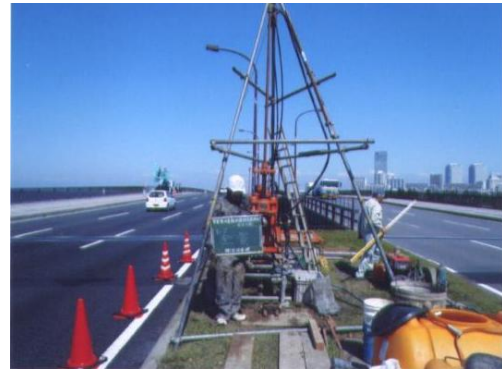
写真 4-2 ボーリング調査状況
