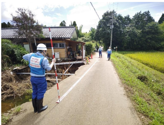
道路の被災規模確認の様子
