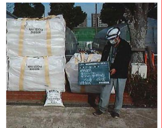
監督職員が立ち会った 状況写真
