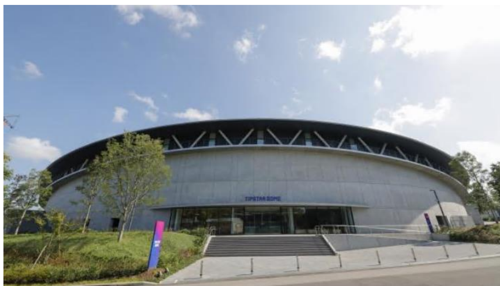
TIPSTAR DOME CHIBA（千葉 JPF ドーム）の外観
