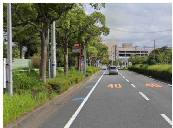
車道混在型(矢羽根路面表示)
