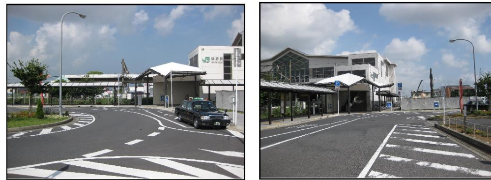
高質空間形成施設(JR浜野駅東口駅前広場)
