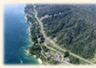
三陸沿岸道路(若手黒山田町)
