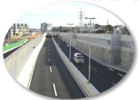
▲ 救急活動に利用されている新港横戸町線 (六川方面から、新港方面へ向かう救急車)
