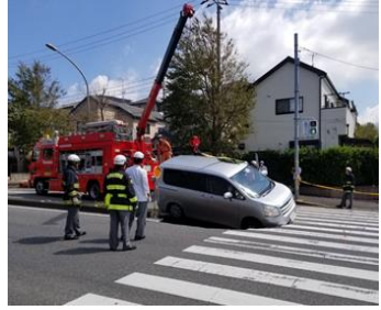
令和元年9月17日 緑区あすみが丘道路陥没事故
