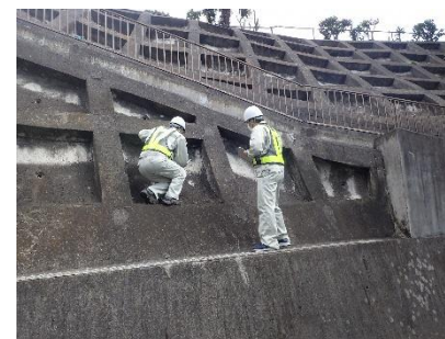
<近接目視点検>
