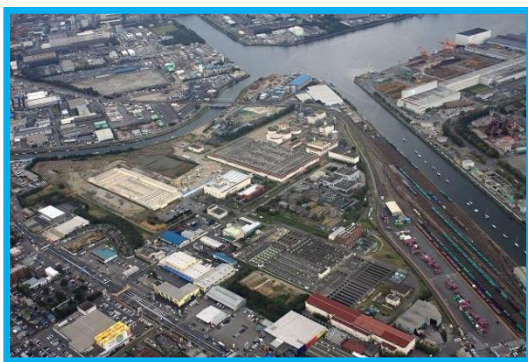
南部浄化センター
