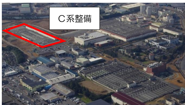
南部浄化センター
