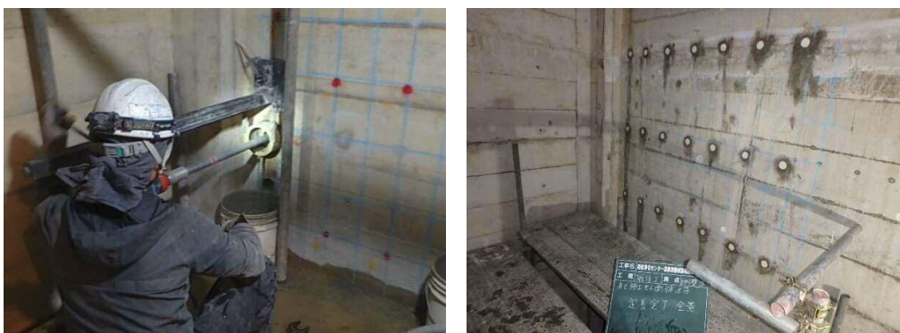
耐震補強工事（補強筋施工）
