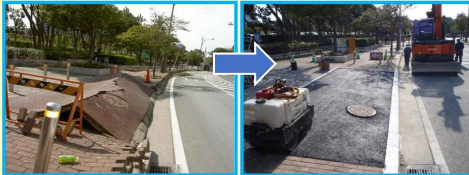
マンホール蓋の浮き上がりの復旧
