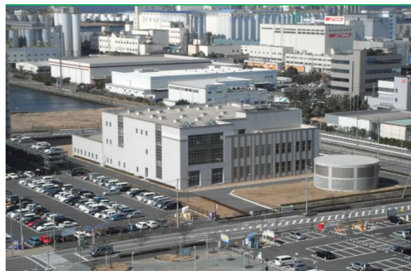
中央雨水ポンプ場
