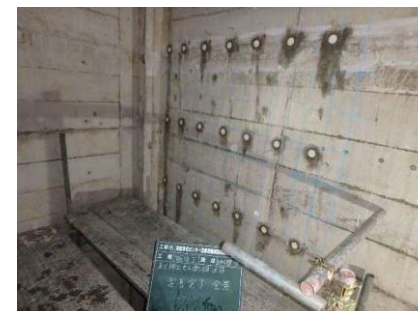
耐震補強工事 (補強筋施工)
