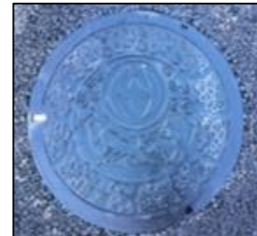
マンホール蓋更新
