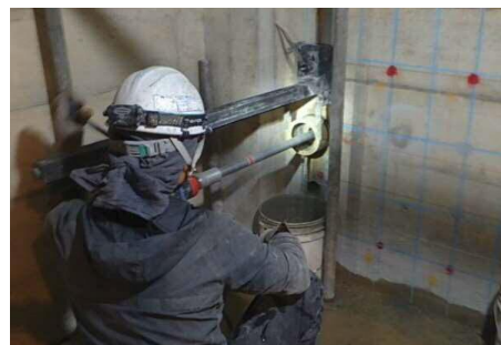
耐震補強工事 (補強筋施工)
