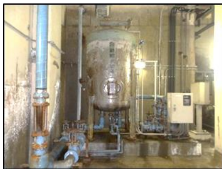
都ポンプ場 (改築前)
