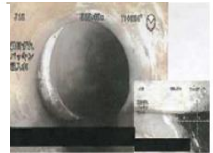
写真4 管の継手ズレ（脱却）
