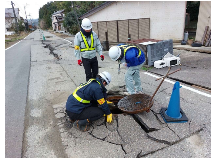
調査状況 3 人孔内確認状況
