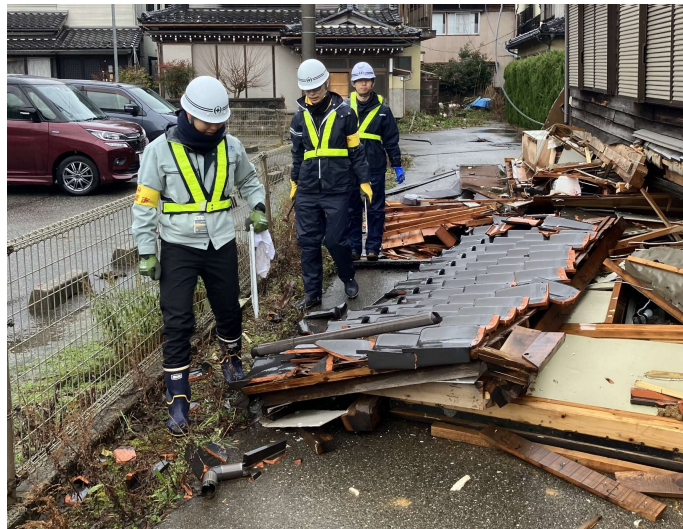
調査状況 2 家屋倒壊付近の調査
