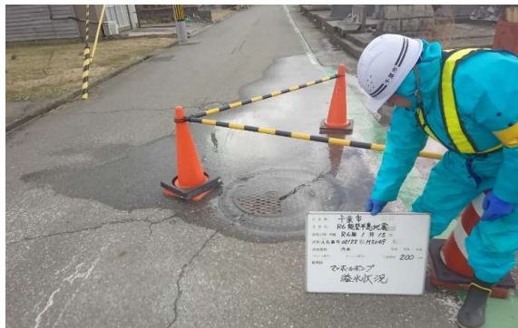
▲マンホールポンプ故障による溢水
