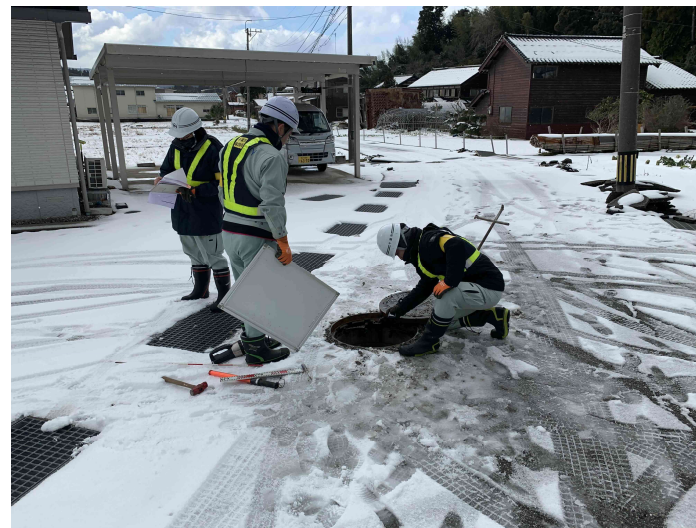
調査状況 1 人孔状況の調査（積雪時）
