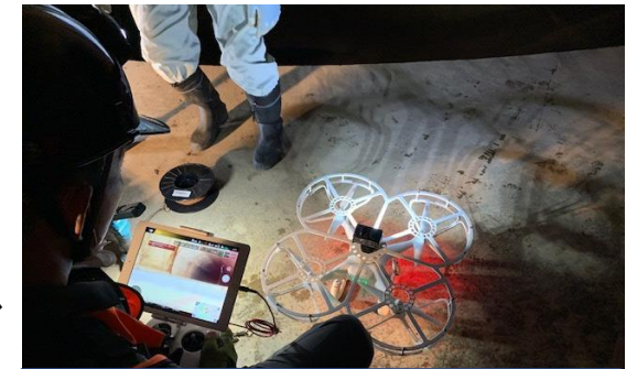
ドローンによる管内調査
