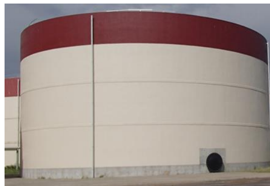
汚泥消化タンク
