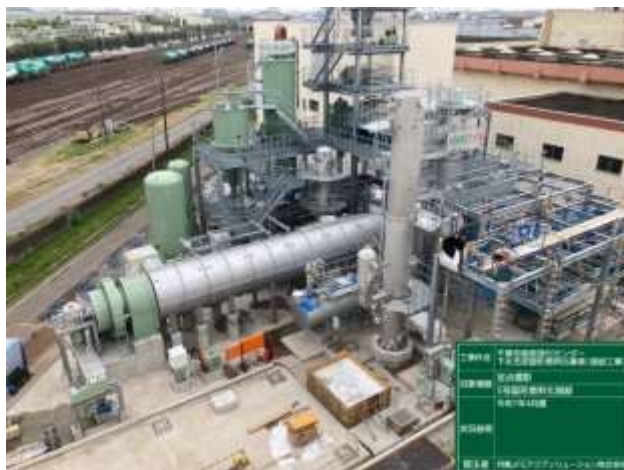
機器（炭化炉等）据付状況
