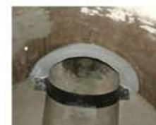
可とう継手設置状況
