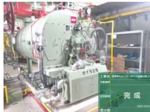
南部浄化センターボイラ設備（改築後）
