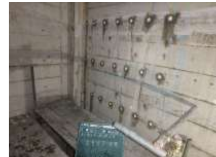
耐震補強工事(補強筋施工)
