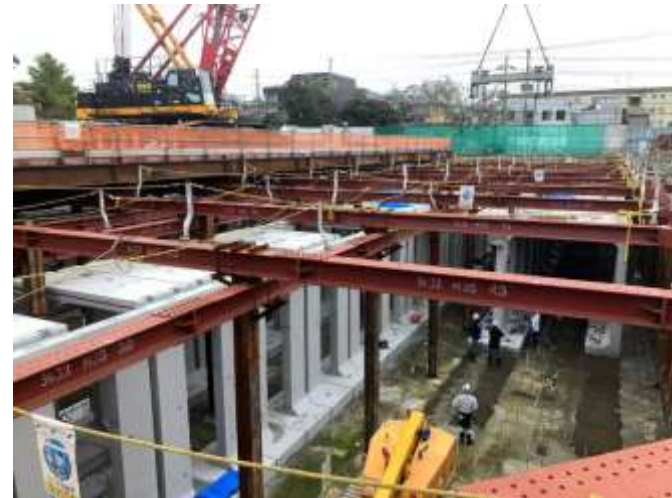
宮崎地区 貯留槽施工状況
