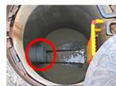
令和6年度能登半島地震（輪島市） 管きょの抜け出し
