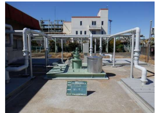
(参考事例)重力濃縮設備の改築
