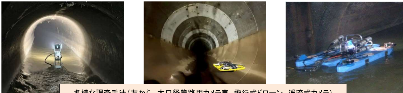
多様な調査手法(左から、大口径管路用カメラ車、飛行式ドローン、浮流式カメラ)
