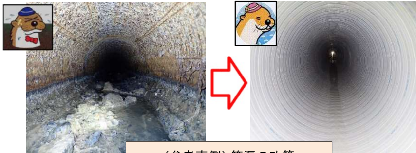
(参考事例) 管渠の改築
