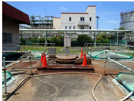
(参考事例)重力濃縮設備の改築
