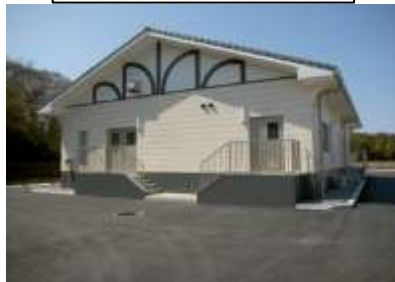
更科地区汚水処理場
