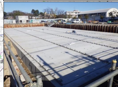
宮崎地区の雨水貯留槽
