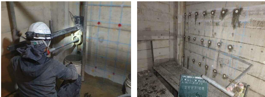
耐震補強工事（補強筋施工）
