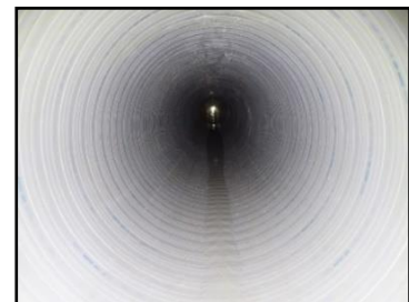
改築後(管更生)
