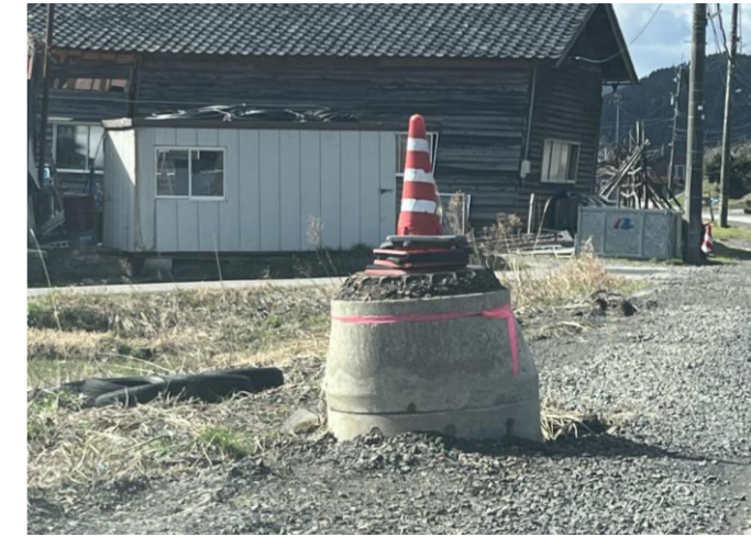
令和6年能登半島地震人孔浮上事例(輪島市)
