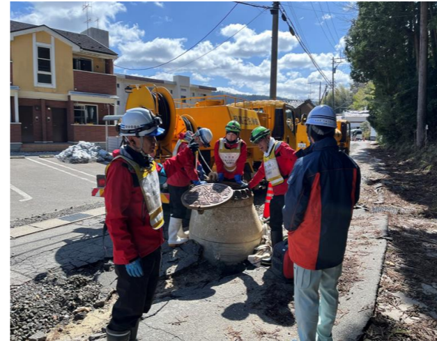
令和6年能登半島地震人孔浮上事例(輪島市)
