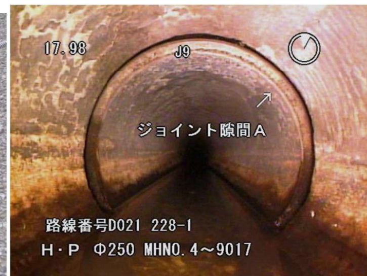
【管内調査状況】
