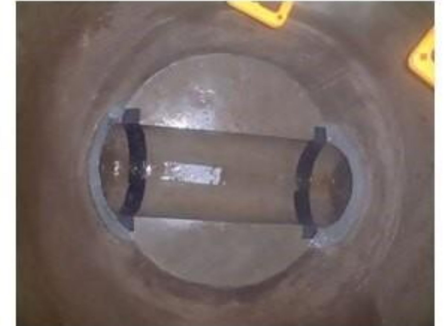
可とう継手設置状況
