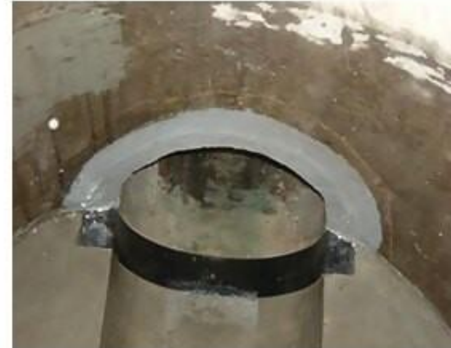
可とう継手設置状況
