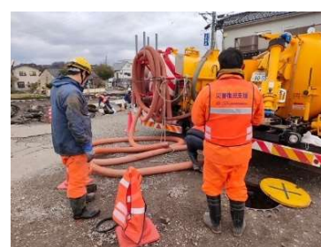
写真2-42 通水確認状況
