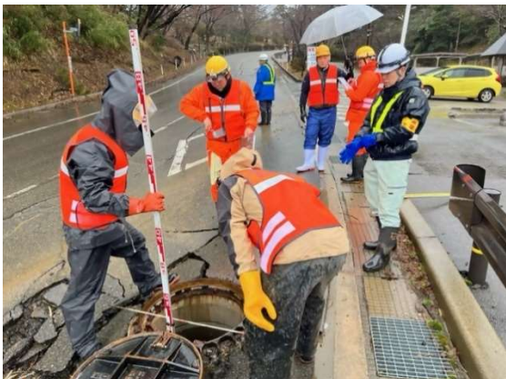
写真 2 - 3 1 人孔調査状況
