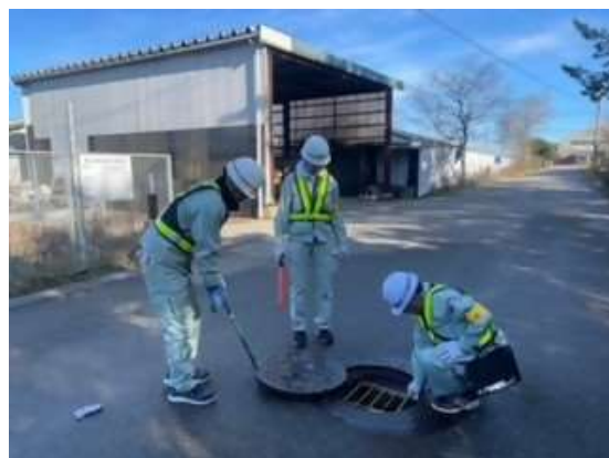
写真 2-1-2 人孔状況確認
