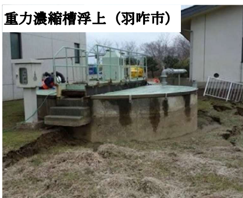
写真1-20 処理場内重力濃縮槽浮上 写真1-21 ポンプ場地下設置機器の水没
