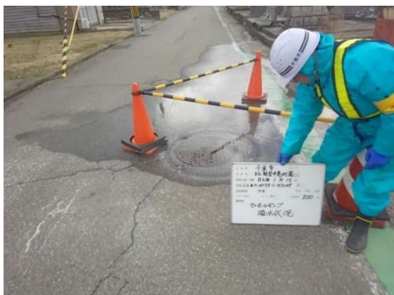
写真 2-1-1 ポンプ故障による溢水
