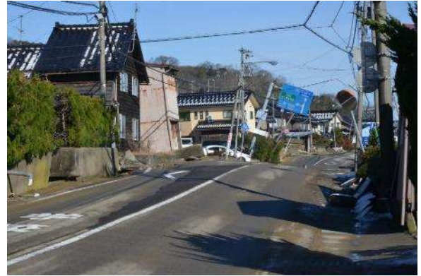
写真1-7 液状化被害の状況 (石川県河北郡内灘町内) (石川県 HP より引用)
