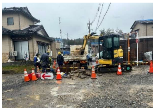
写真 2 - 3 3 土工班による応急対応工事
