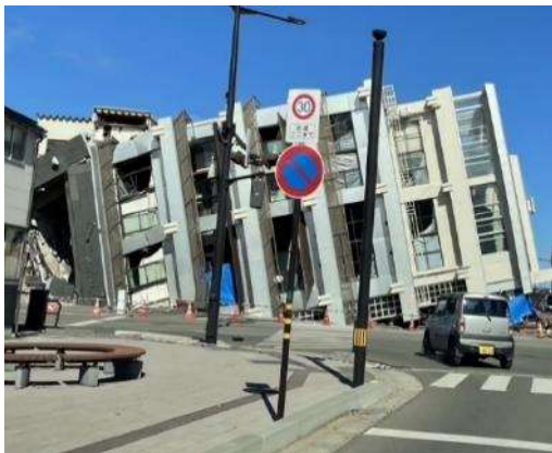
写真1-4 建築物の倒壊状況 (輪島市河井町付近)
