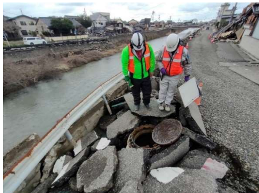
写真 2 - 3 6 道路陥没
