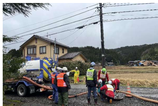
写真 2 - 4 6 吸引車の稼働状況
