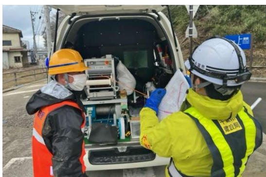
写真 2-28 TVカメラ調査状況
