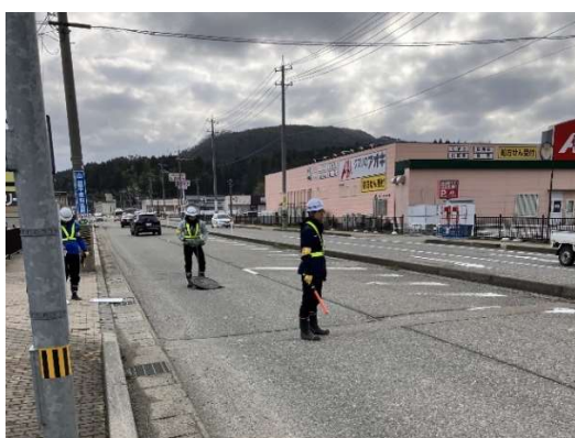
写真 2-26 交通誘導実施状況①
