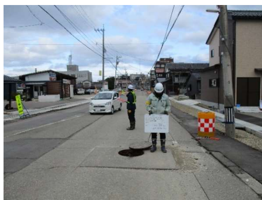
写真 2-27 交通誘導実施状況②
