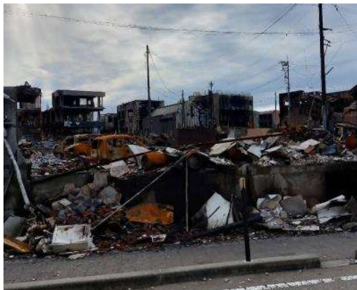
写真1-5 火災により焼失した市街地 (輪島市 輪島朝市付近)
