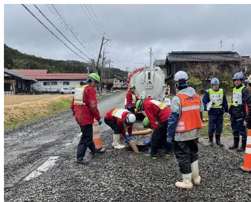
写真 2 - 3 2 洗浄車・吸引車稼働状況
