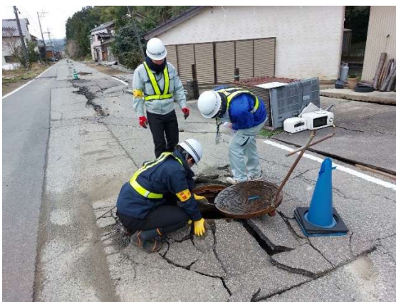
写真 2-15 人孔内確認状況
