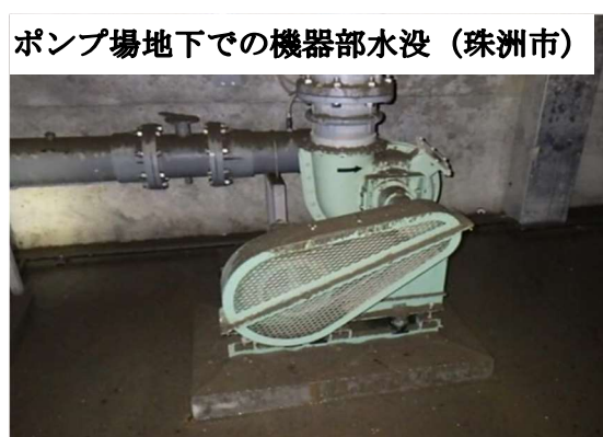
写真1-20 処理場内重力濃縮槽浮上 写真1-21 ポンプ場地下設置機器の水没
