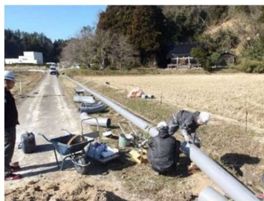
写真1-19 仮設圧送管の布設
