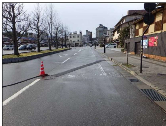
写真8 仮設配管埋設完了
