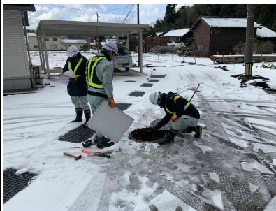
調査状況 1 人孔状況の調査（積雪時）
