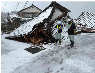
調査状況 2 人孔調査の記録（積雪時）
