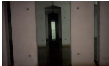
貯留槽内の様子（R7.8）
