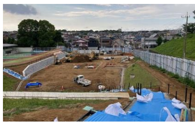
公園復旧工事の様子(R8.6)
