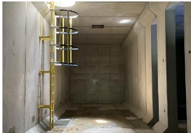
貯留槽内の様子(R6.3)
