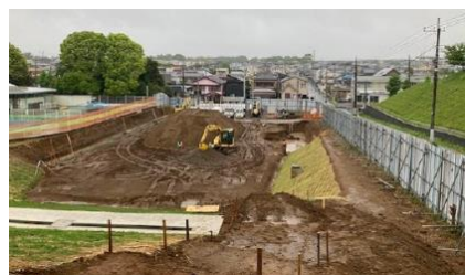
公園復旧工事の様子(R8.4)
