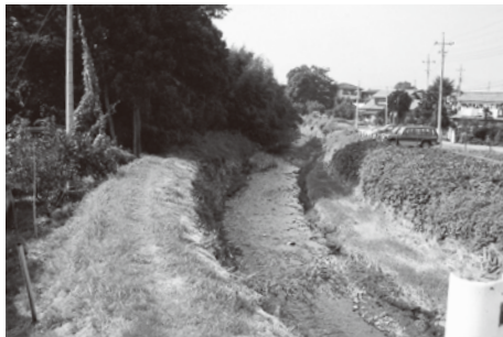
梁谷川 群馬県高崎市
