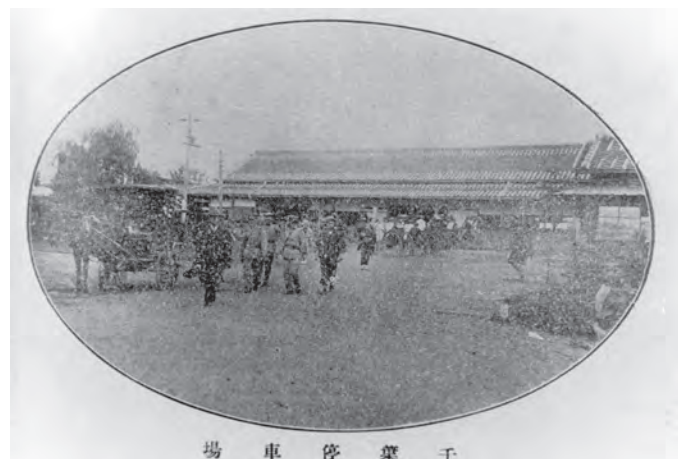
写真3 明治27年頃の千葉駅（『千葉街案内』52頁）
