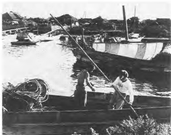
船溜り内部（昭和31年9月撮影）
