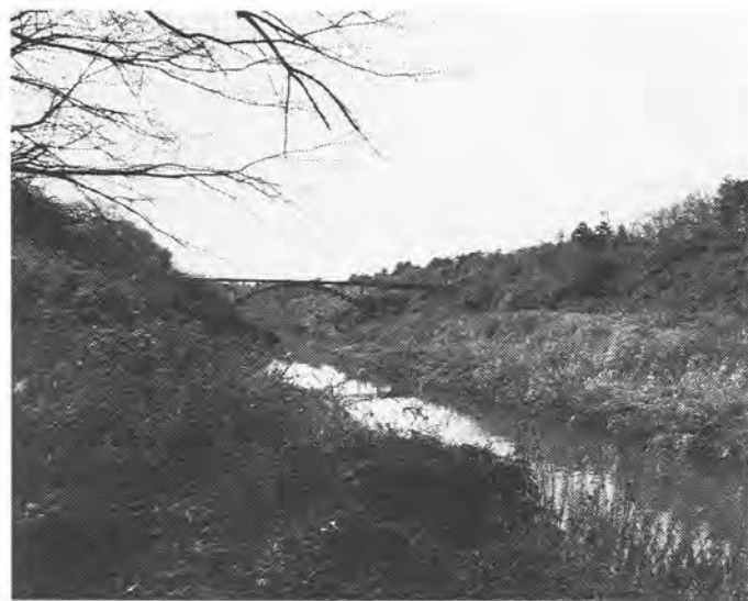
沼津藩と庄内藩の工事場の境付近 (千葉市横戸町「元池弁天宮」より弁天橋をのぞむ)
