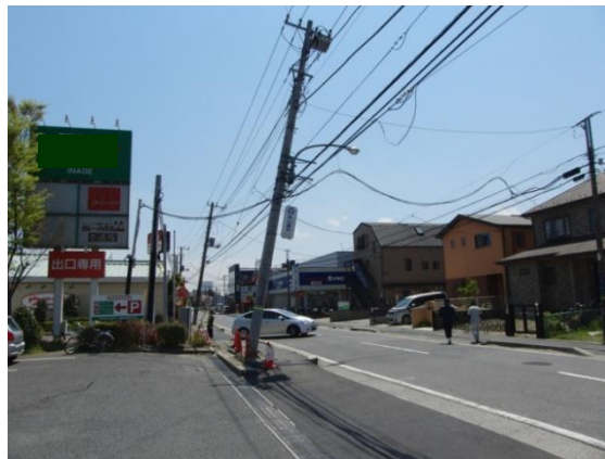
液状化により傾いた電柱（美浜区）
