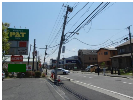
液状化により傾いた電柱（美浜区）
