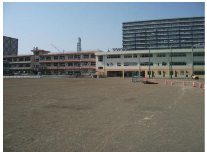
【向かって右側 新宿小学校「分教室」の外観】
