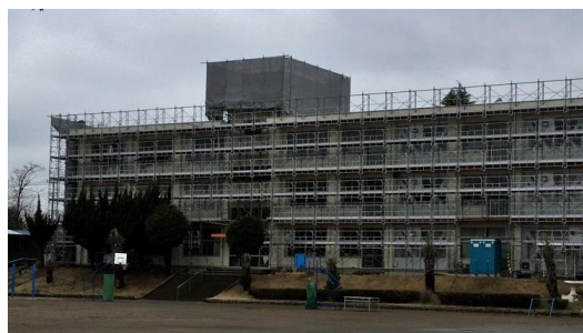
大規模改造工事が順調に進む第一小
