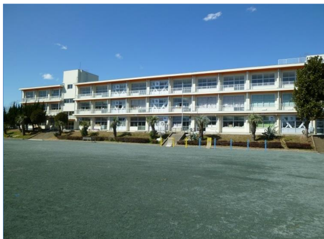
校庭の改修も終了し統合校の開校を待つ校舎 (グラウンドには、風が吹いても飛びづらいグリーン サンドが敷かれています)
