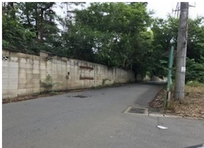
(若葉区大宮町2032番地付近)
