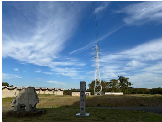
写真 送電鉄塔
