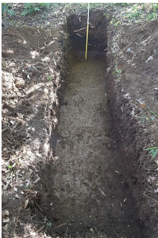
試掘2 トレンチ (北から)
