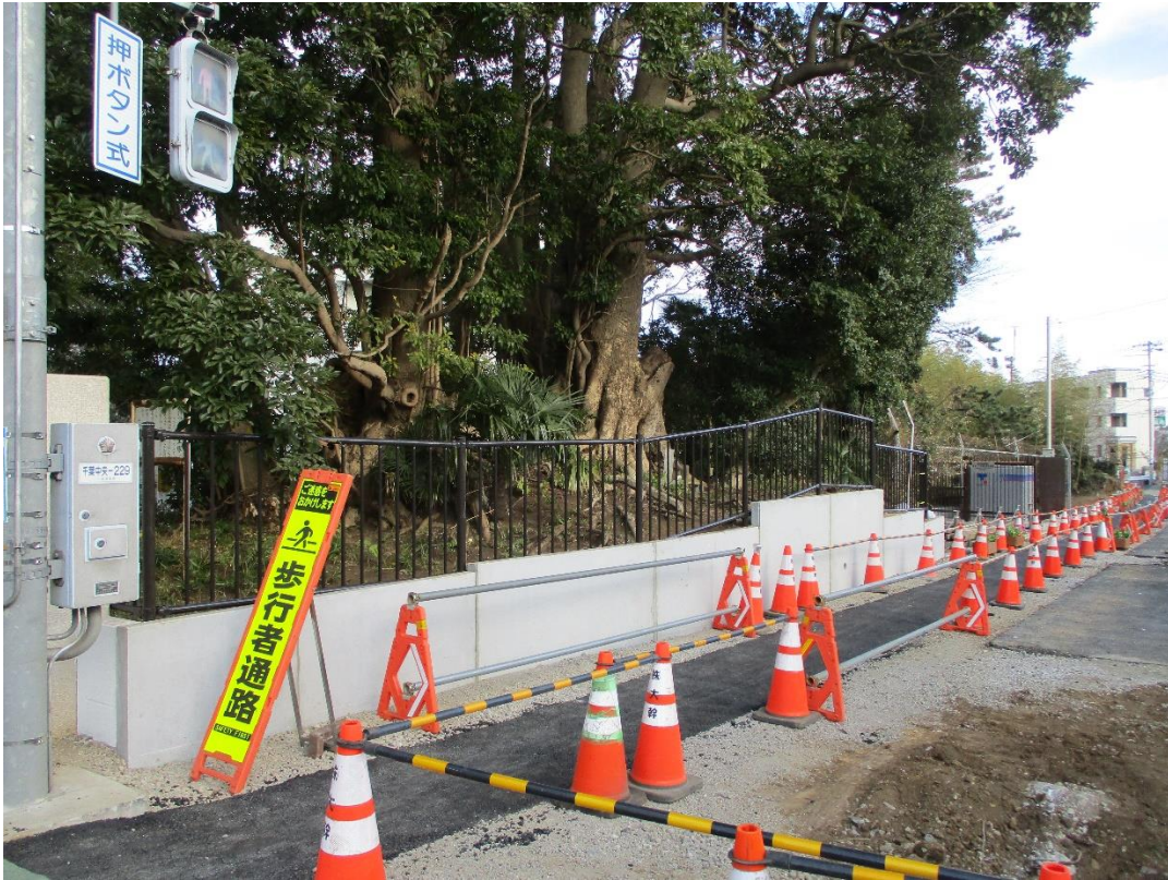
写真 七天皇塚3号塚 フェンス設置状況
