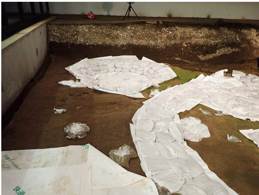
土のうによる部分保護(住居壁面等) 0828 撮影
