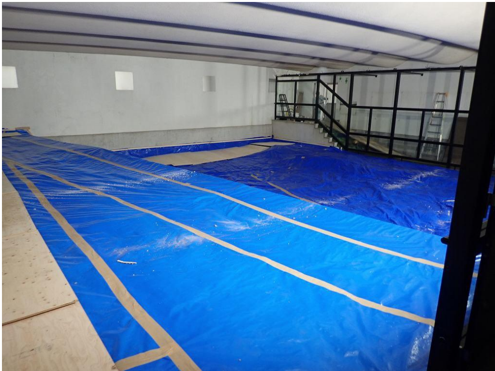
全面にブルーシートを設置 0929 撮影
