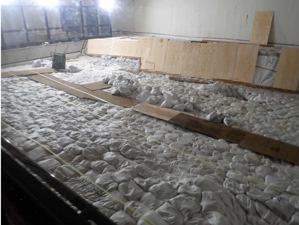
防湿透水シートの上から全面土のう設置 0925 撮影
