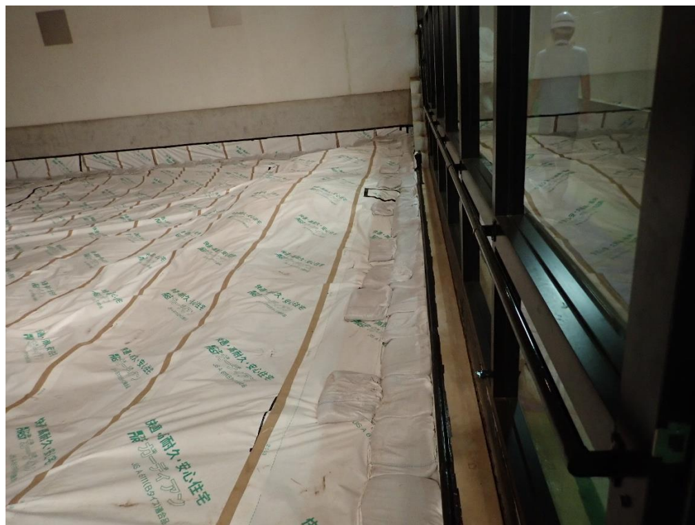
全面に透湿防水シートを設置 0917 撮影
