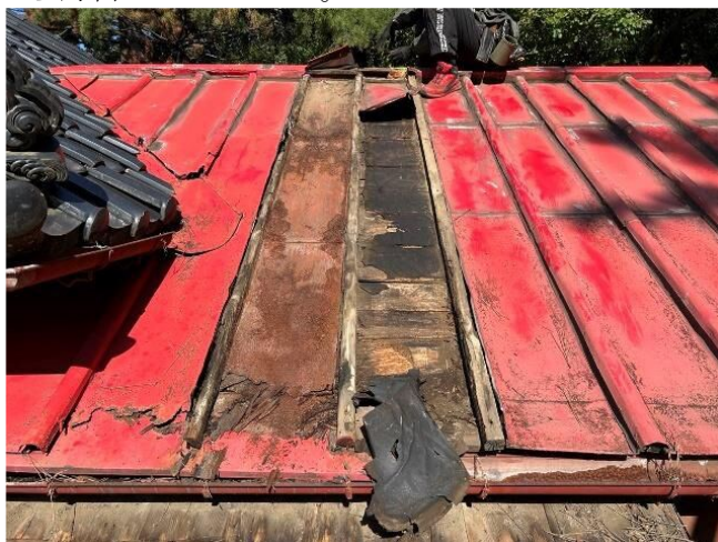
既存ルーフィングの状況
