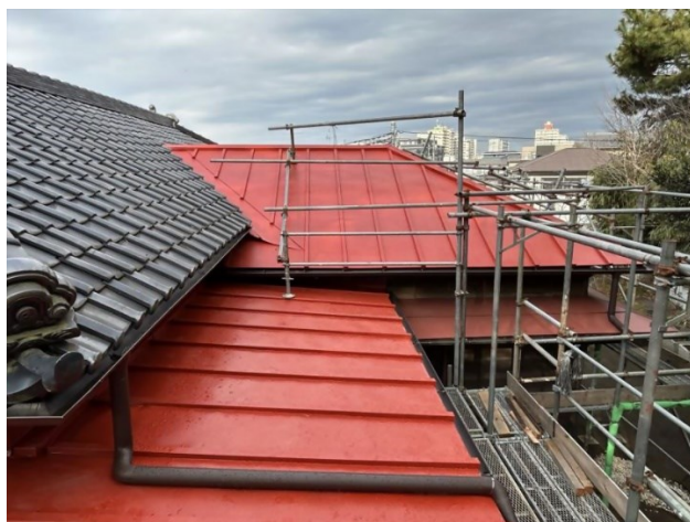
屋根塗装上塗りの施工状況
