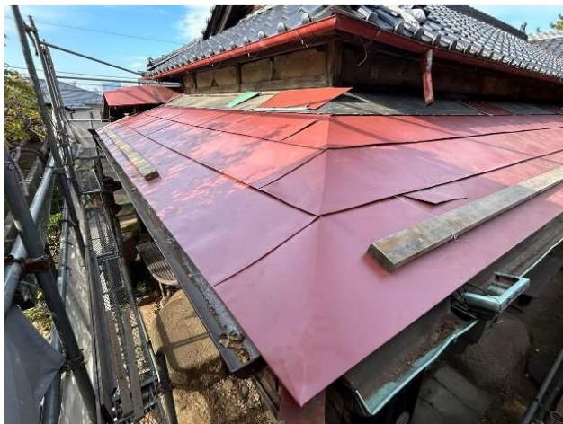
縁側屋根 隅棟峰の施工状況
