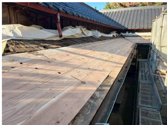
野地板施工状況
