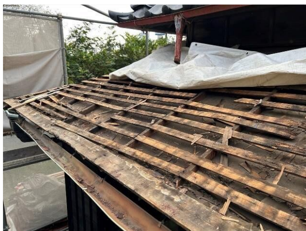
野地板の状況
