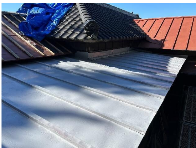
屋根塗装下塗りの施工状況
