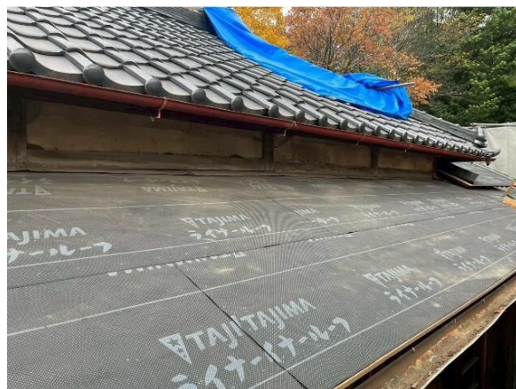
アスファルトルーフィング敷設状況
