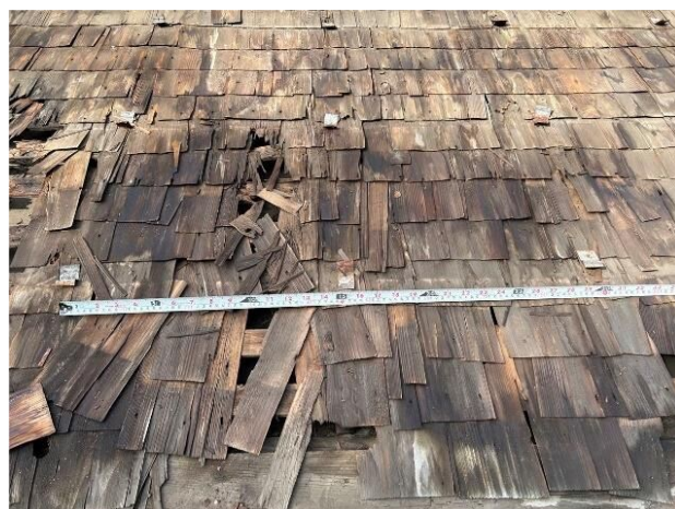
トントン葺きの状況
