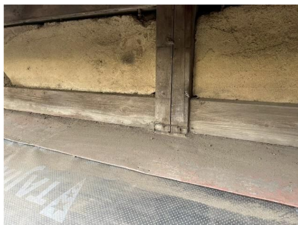
当初葺き材の残存状況
