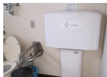
トイレ内におむつ交換台を設置
