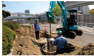
掘り起こし作業の様子
