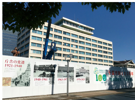
千葉市役所新庁舎工事仮囲い (2020.9月～2021.12月)
