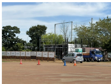
【体育倉庫も完成間近】
