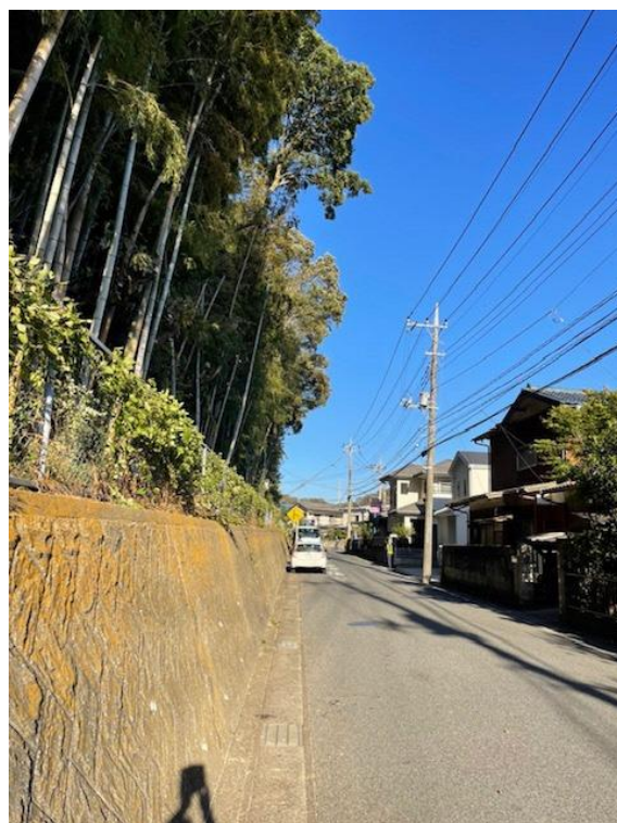
【伐採後、フェンスに沿って払われた枝】
