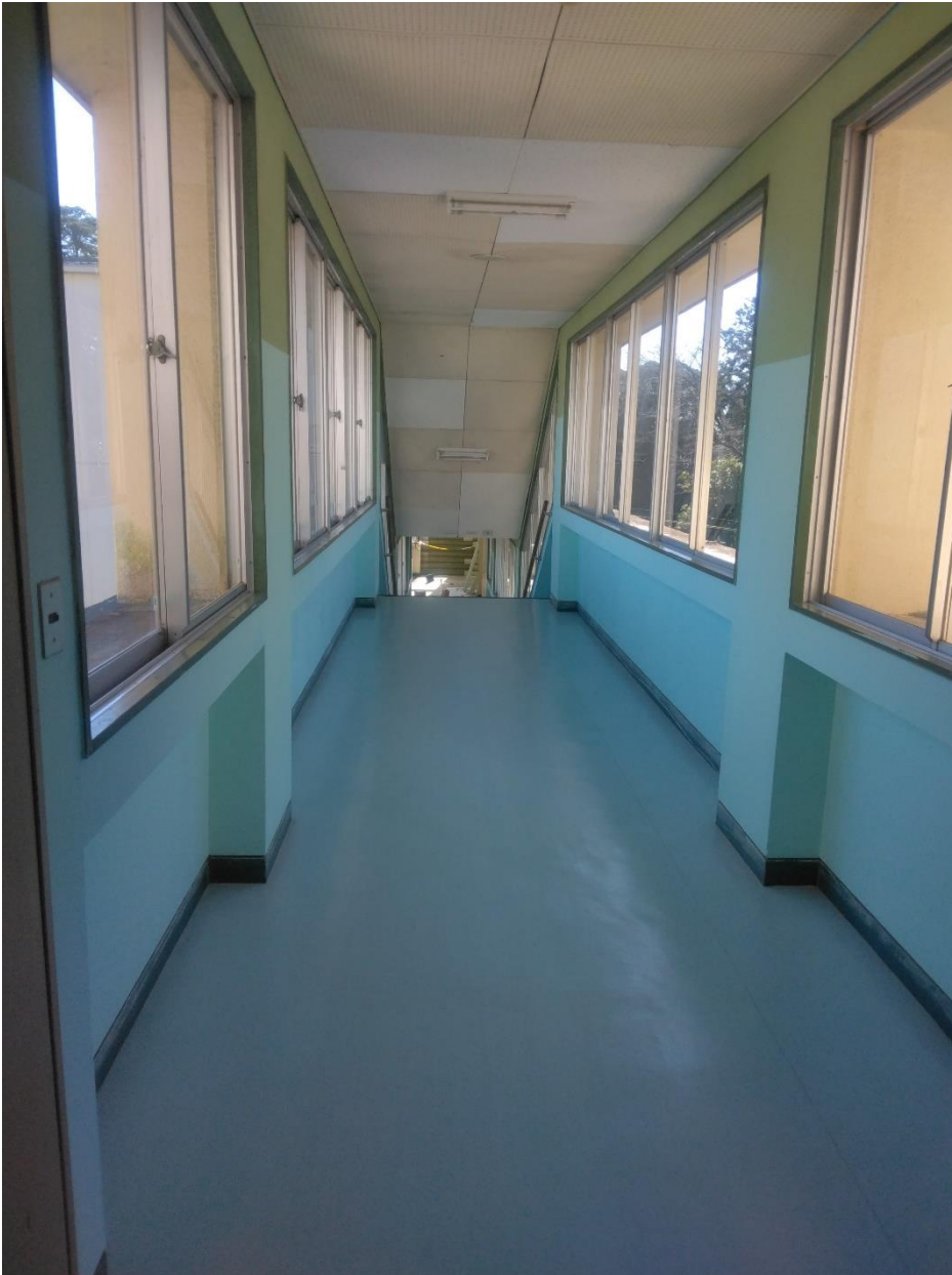
中央棟から管理棟方向を見た様子
