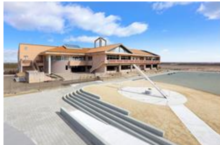
③山元町震災遺構 中浜小学校
