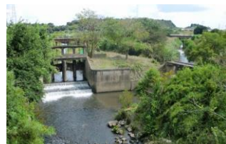
丹後堰取水口付近
