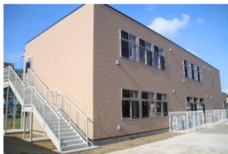
非常階段も立派です。
