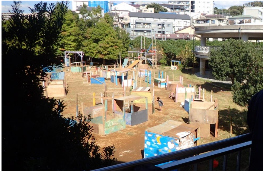
【子供たちの手で作る「こどもゆめ横丁(建設中)」】
